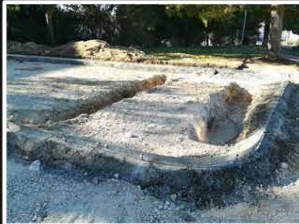
*Demolição e remoção de pavimento In Situ, betonilha, lintel e lancil existente*
